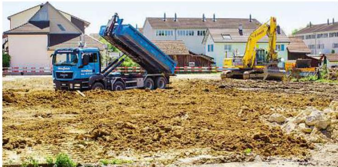
Zuerst wurde Erdmaterial auf den Bauplatz der Mehrzweckhalle zugeführt, nachher wird es beim Aushub der Baugrube wieder wegtransportiert
